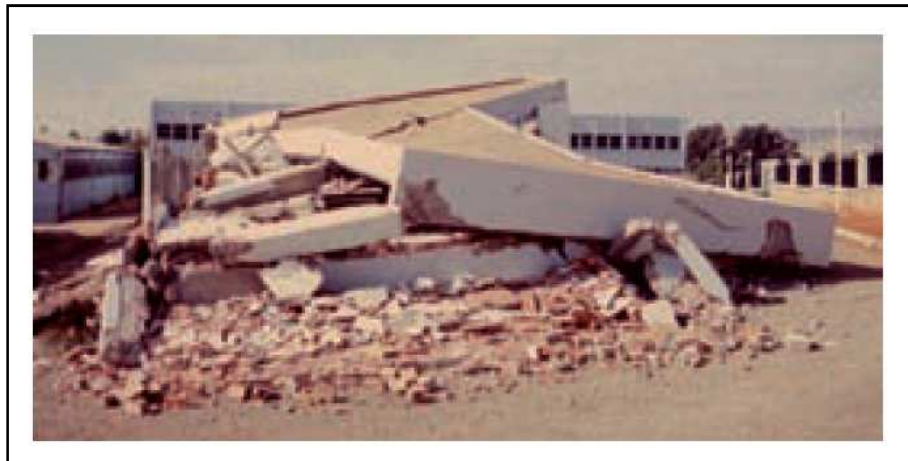
Figure 2.5 Effondrement dû à la torsion, el asnam 1980
